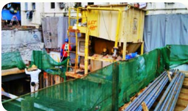
建築地盤的污水處理設施
