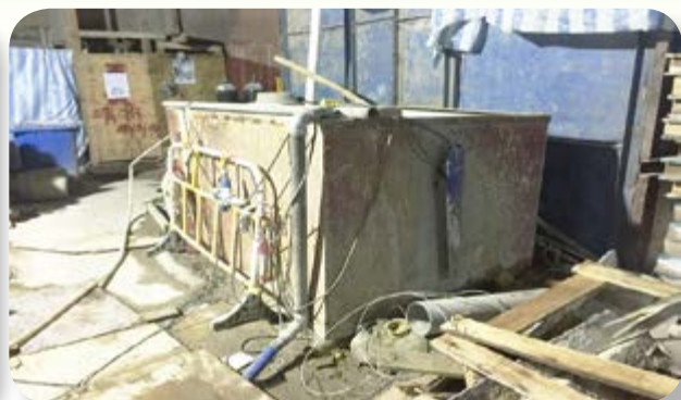
建築地盤的污水處理設施
