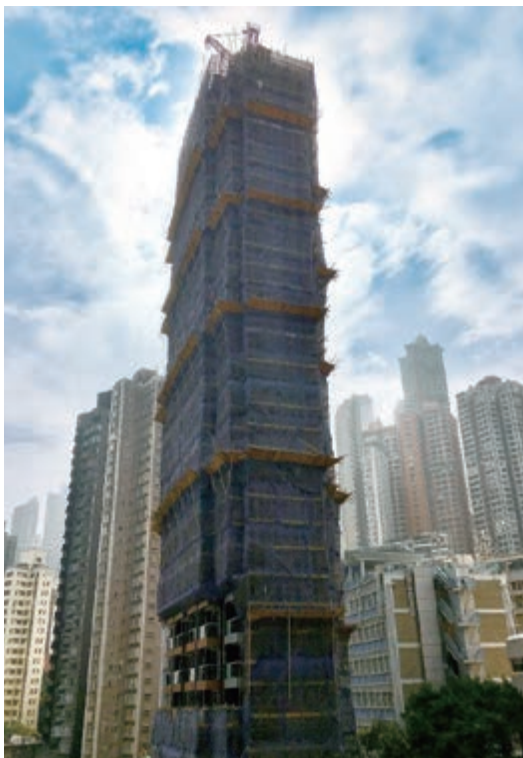
上蓋建築工程現正進行中
