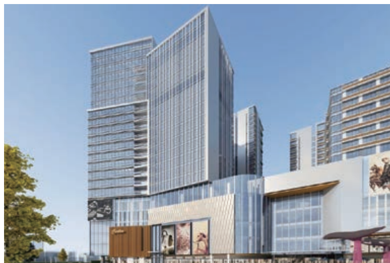
富豪國際新都薈之商業/寫字樓大樓 (*)
